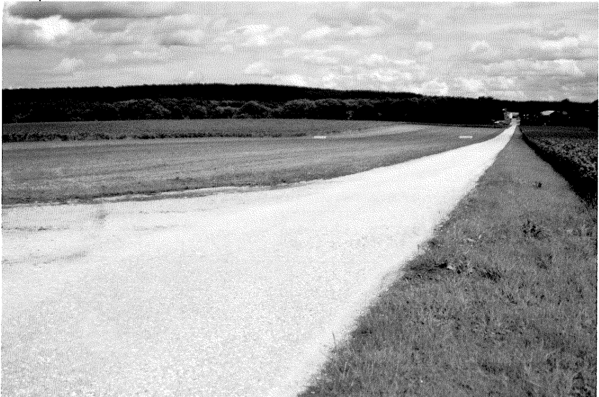
Landeplatz mit Blick nach Ost
